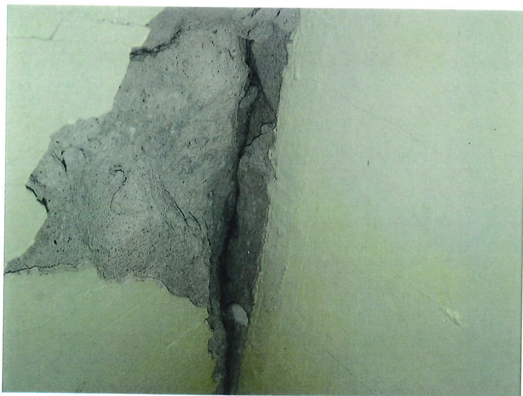
Fot.6. Widok wykonanej odkrywki w pęknięciu narożnika sali gimnastycznej – brak dylatacji.
