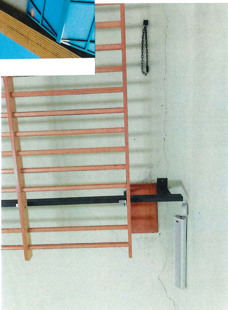
Fot.8. Skośne zarysowanie ściany sali gimnastycznej na wysokości drabinek do ćwiczeń.
