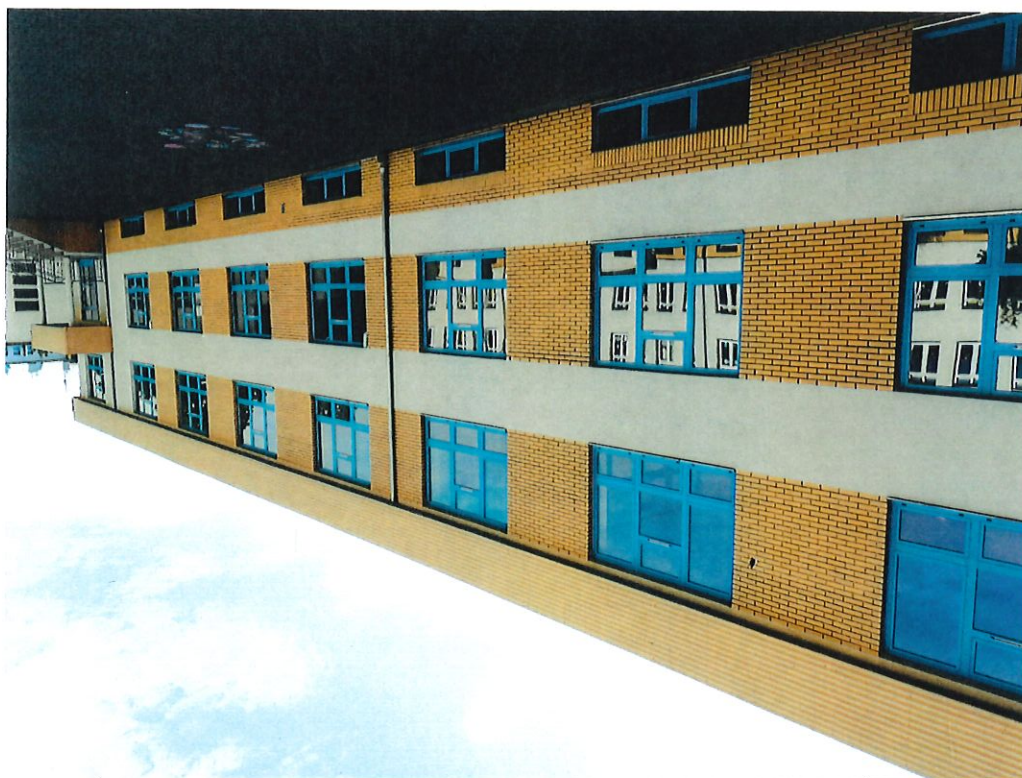
Fot. 18. Widok elewacji wschodniej bloku dydaktycznego – brak dylatacji w projektowanym miejscu.
