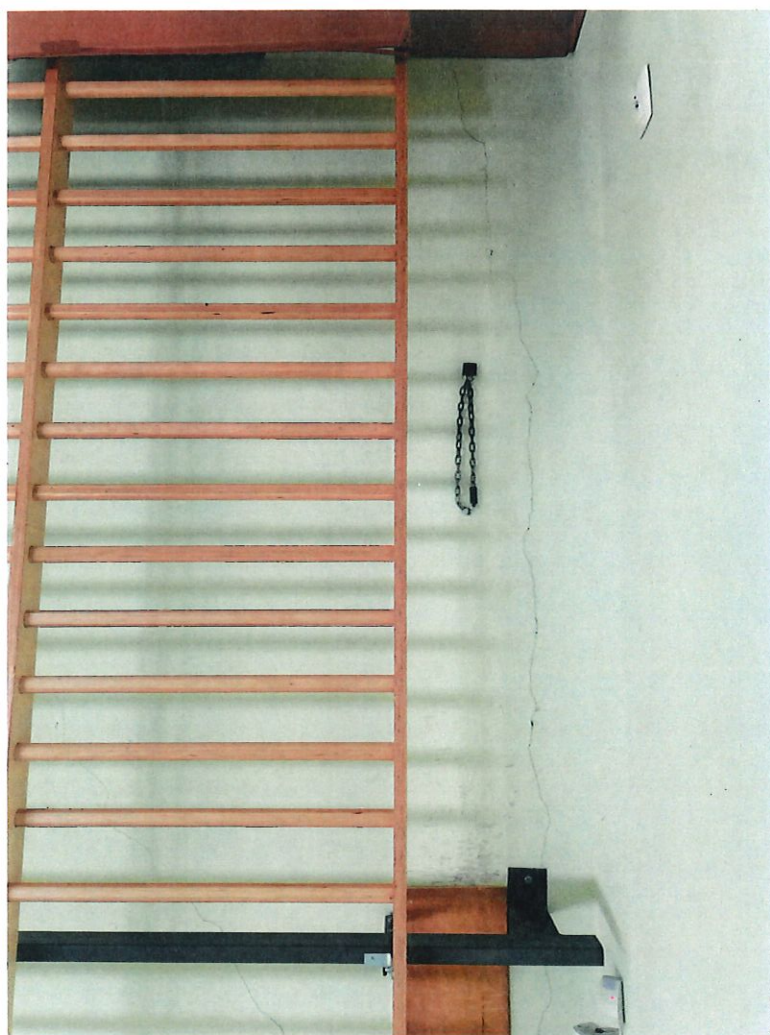
Fot. 3. Pęknięcie pionowe narożnika ściany sali gimnastycznej na całej jej wysokości.
