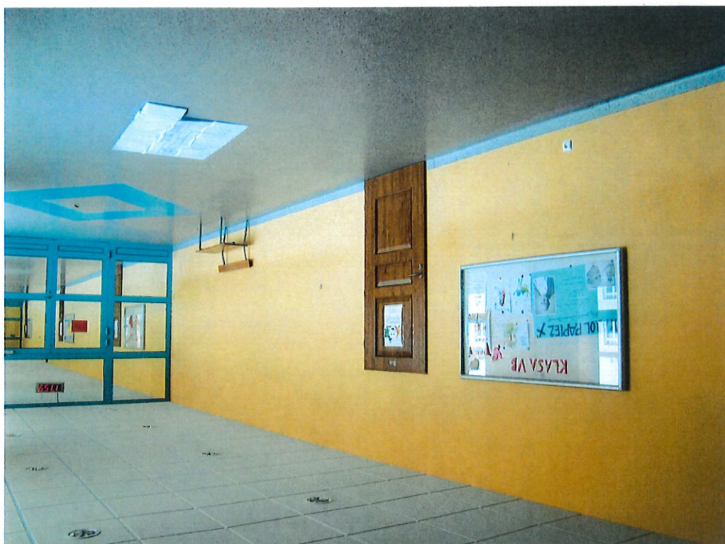
Fot. 17. Widok ściany wewnętrznej korytarza bloku dydaktycznego – brak dylatacji w projektowanym miejscu.
