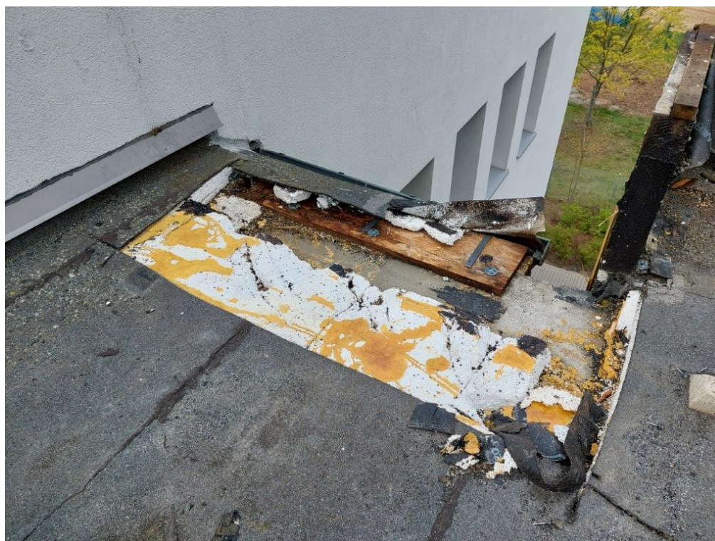
Fotografia 14. Zakres zniszczenia dachu na jego części bez attyki.
