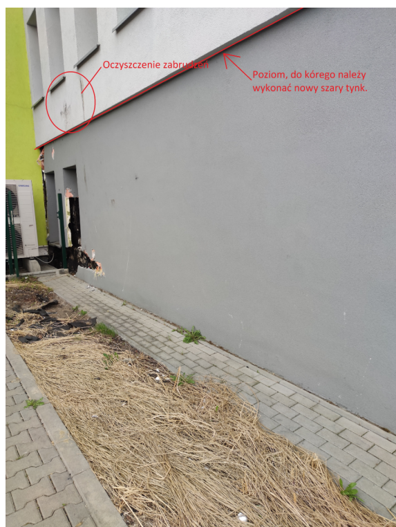
Fotografia 12. Zakres rozbiórki szarego tynku i miejsce zabrudzenia tynku jasnoszarego.
