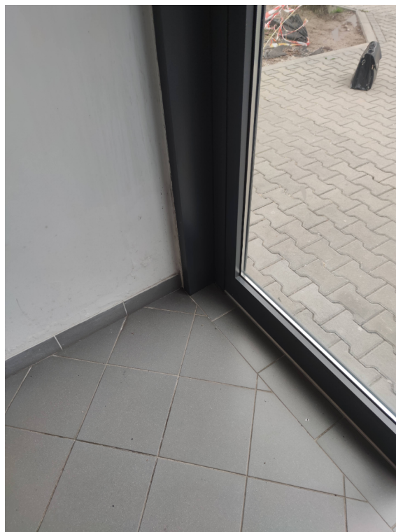
Fotografia 5. Połączenie słupka fasady z posadzką w budynku.
