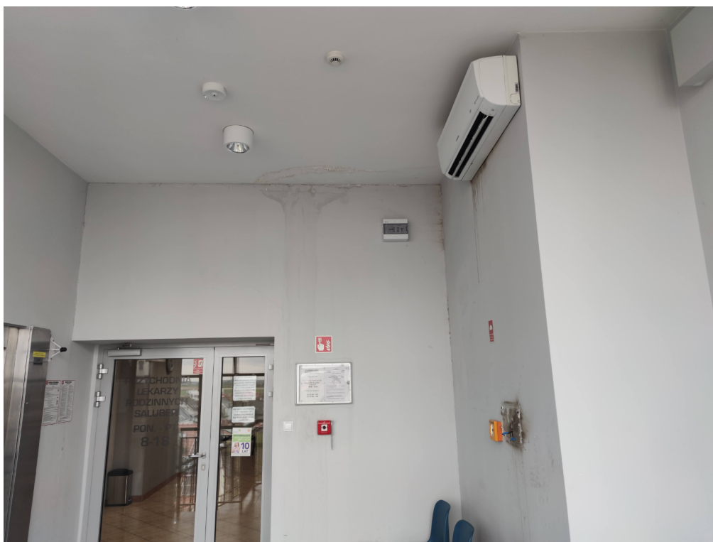
Fotografia 17. Zacieki i zabrudzenia na ścianach najwyższej kondygnacji.
