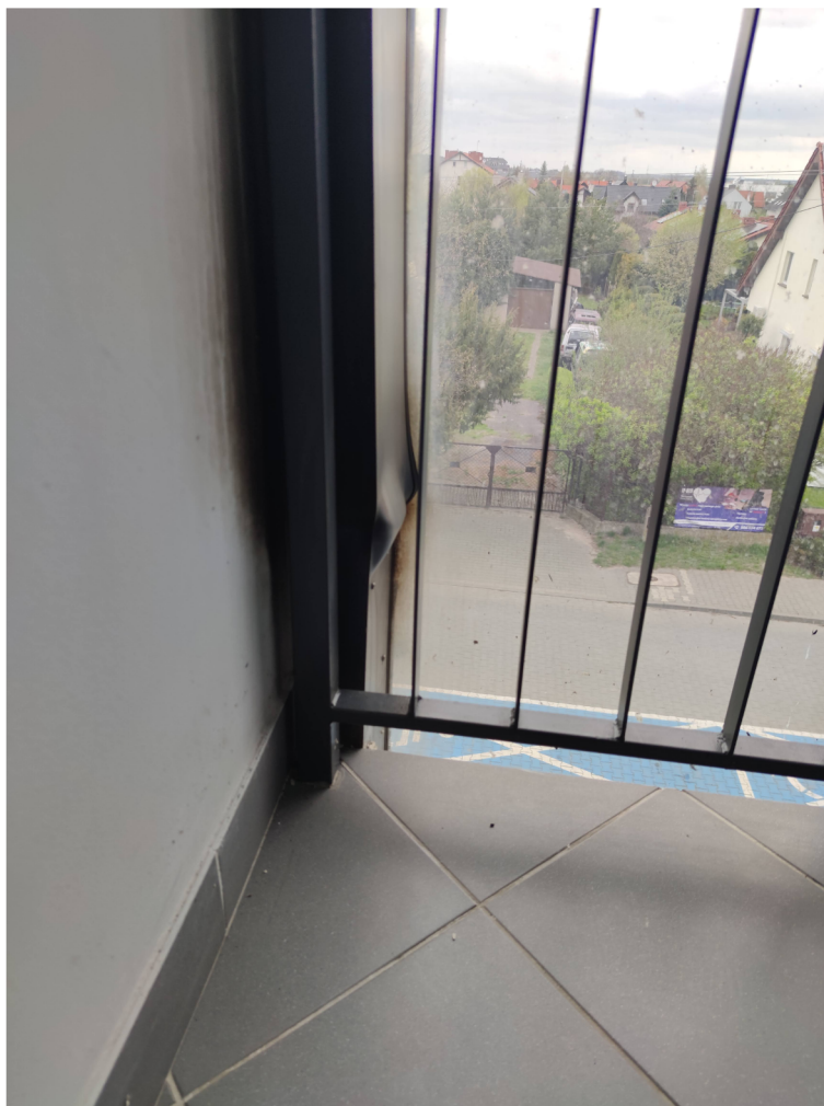
Fotografia 2. Uszkodzenie słupka fasady
