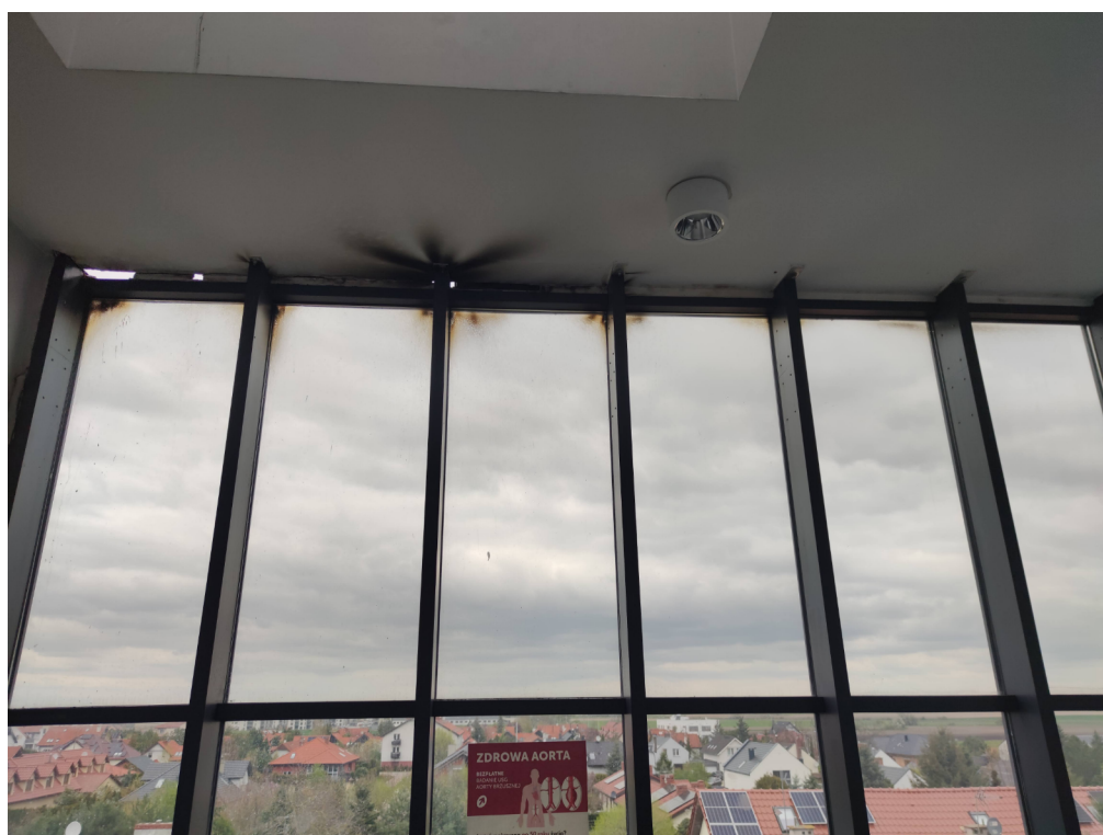
Fotografia 6. Uzupełnienie wykończenia wewnętrznego między górnym pasem fasady a stropem klatki schodowej.
