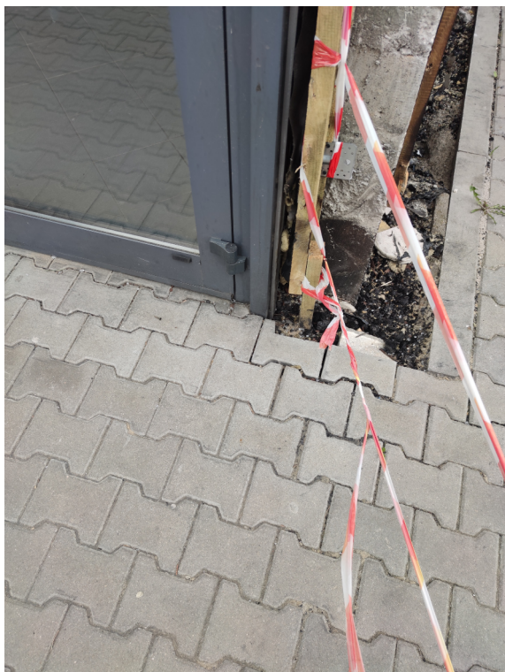
Fotografia 4. Połączenie słupka fasady z chodnikiem na zewnątrz budynku.
