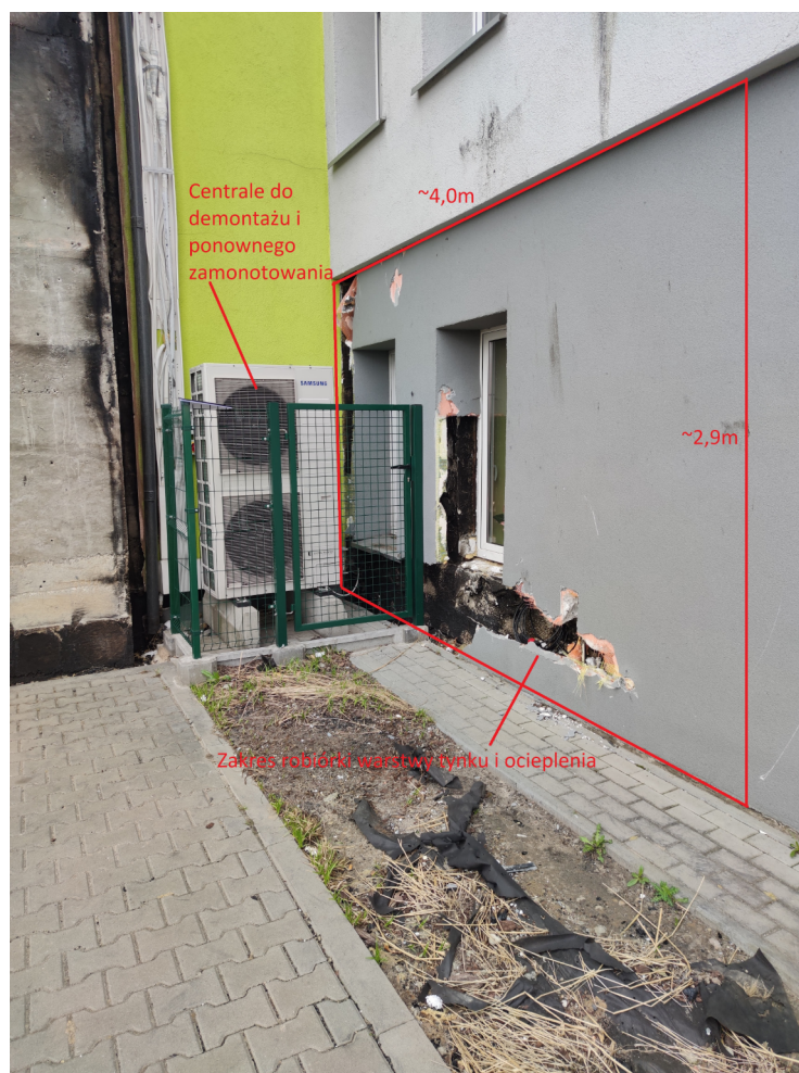
Fotografia 11: Zakres wymiany warstwy tynku i ocieplenia – widok elewacji.
