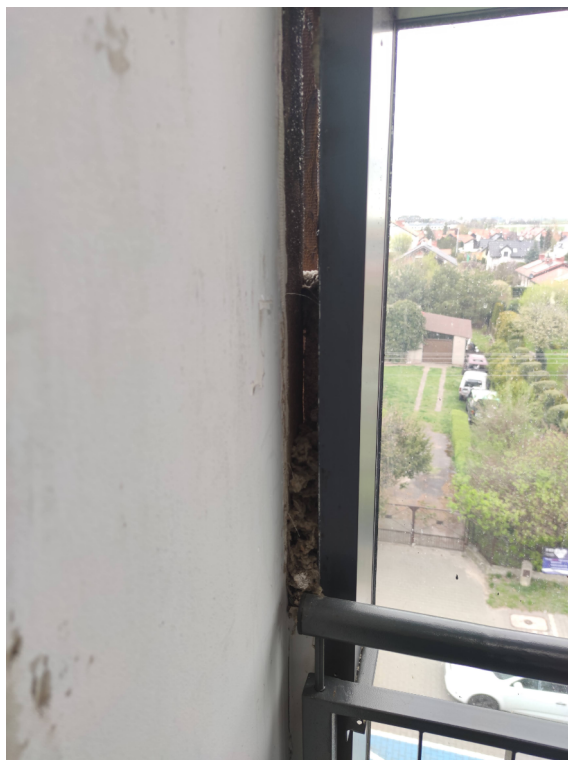
Fotografia 7. Uzupełnienie wykończenia wewnętrznego między słupkiem fasady a ścianą.
