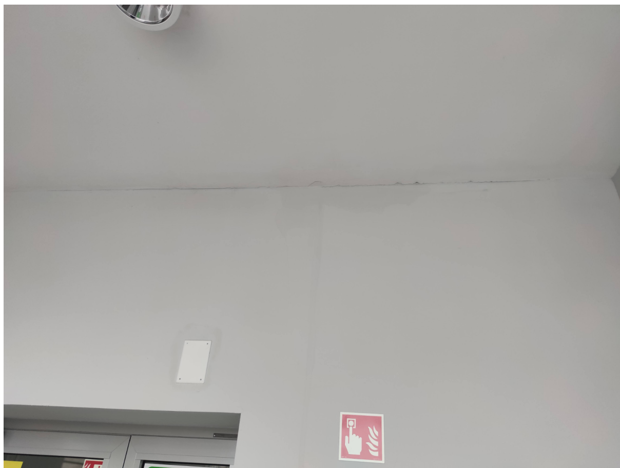
Fotografia 21. Zacieki na ścinach 2 kondygnacji.
