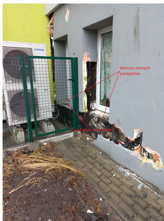
Fotografia 13. Parapety w oknach na parterze do wymiany.
